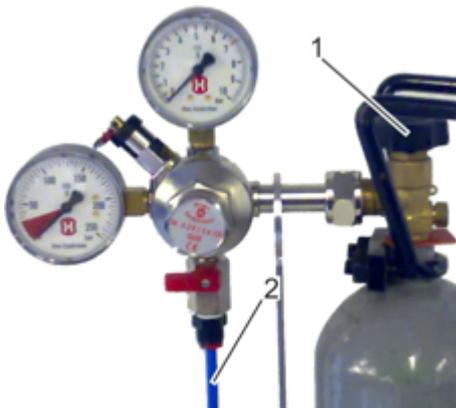
Abb. J: CO<sub>2</sub>-Flaschenventil öffnen
